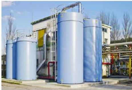
Fig. 4. Emissioni del biotrickling nell'impianto di depurazione dell'industria cartaria
