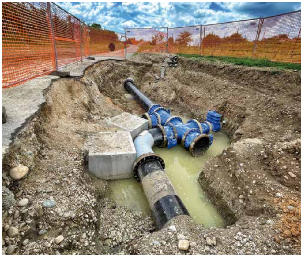
Nodo idraulico di estremità della linea risanata
