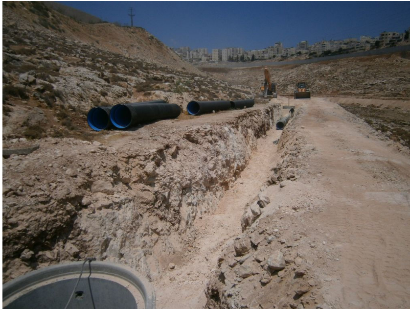
Figura 8. Tipico esempio di cantiere per la posa di condotte di grande diametro.
