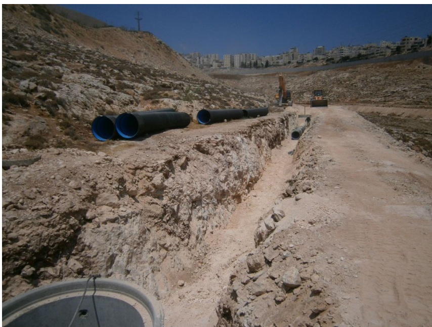
Figura 11. Tipico esempio di cantiere per la posa di condotte di grande diametro.
